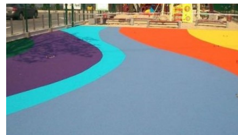
Podłoga bezpieczna poliuretanowa wylewana łącznie 185,79m 2
